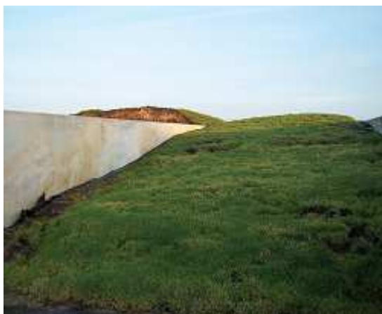
Couverture végétale des silos (semi d'escourgeon)
