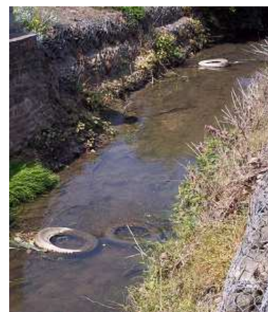
Pneus servant de lest pour les silos
