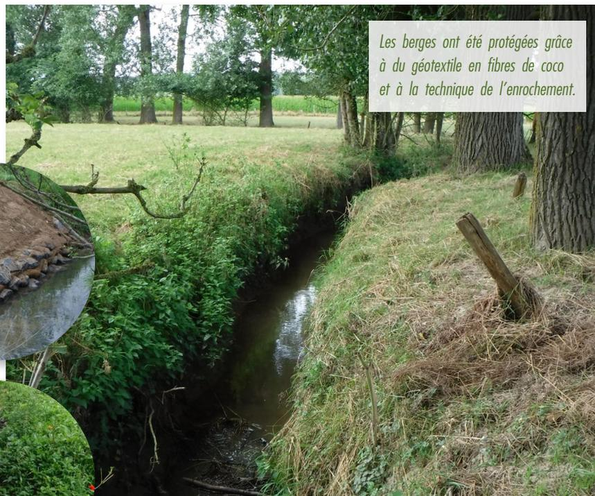
Les berges ont été protégées grâce à du géotextile en fibres de coco et à la technique de l'enrochement.
