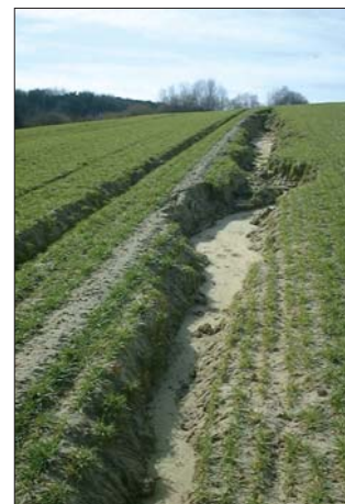
Figure 3d : Ravine profonde (env. 0,70 m) et relativement étroite formée à partir des traces de roues. Photo : UCL, unité de Génie rural
