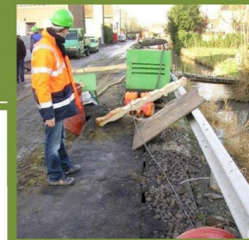
Le premier collecteur a été posé en 1980. Aujourd'hui, le réseau s'étend sur 289 km.
